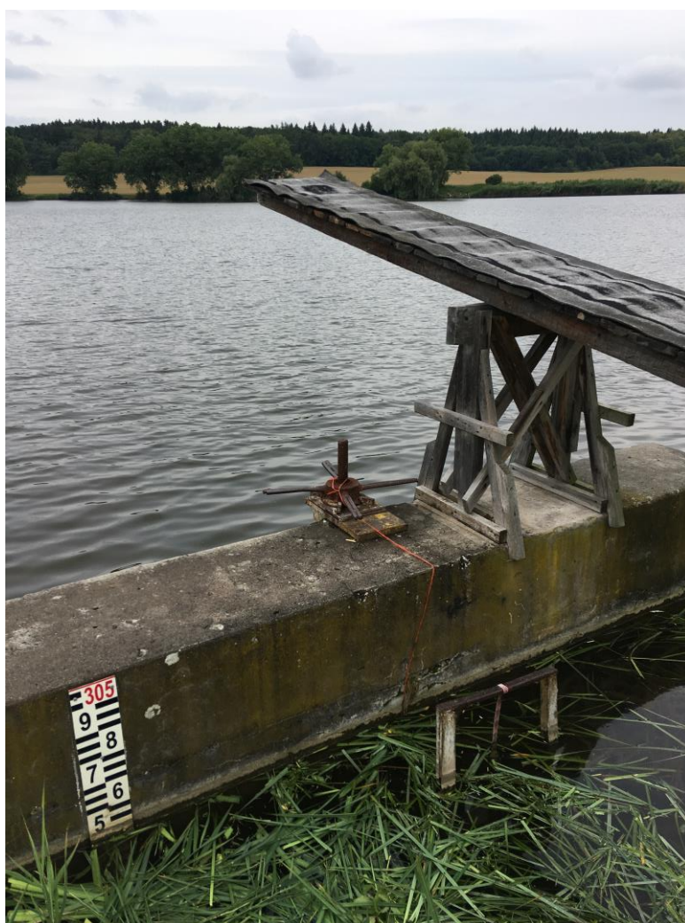
Foto č. 2: Stávající výpustný objekt.
